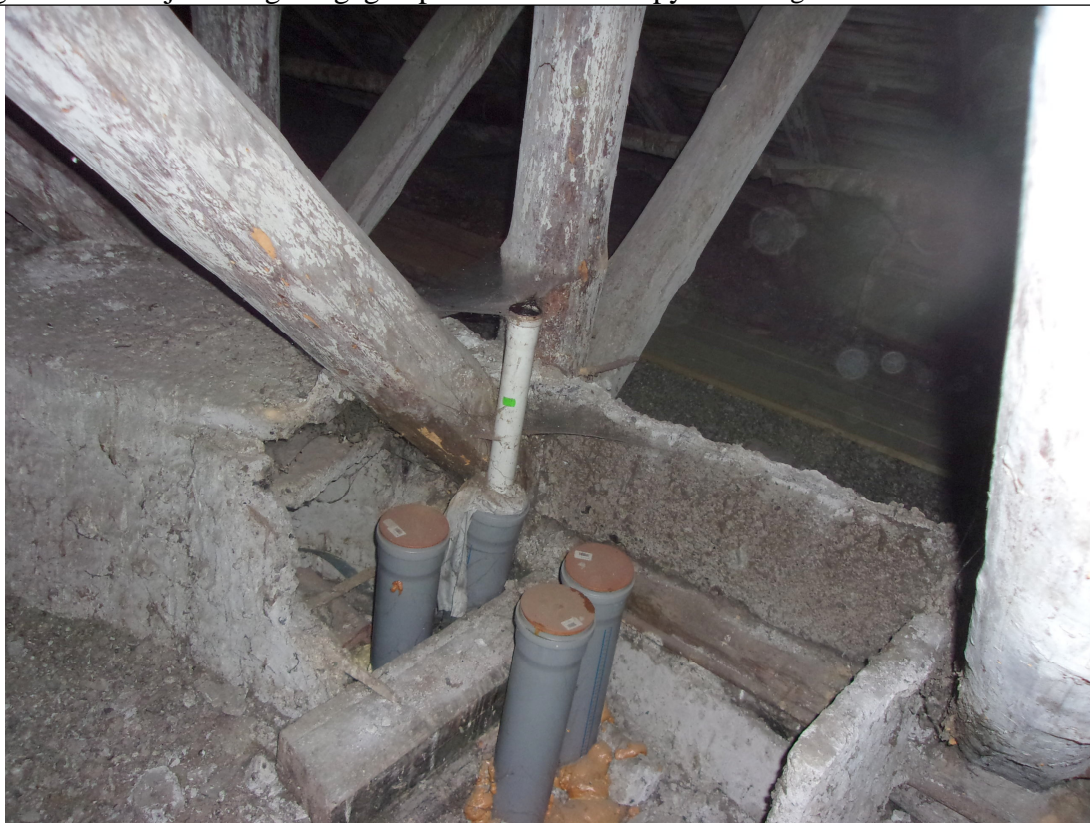
Stogo konstrukcijos apatinis mazgas. Šalia dalinai suiręs betoninis vėdinimo kanalas Fotografuota 2025-01-16.
