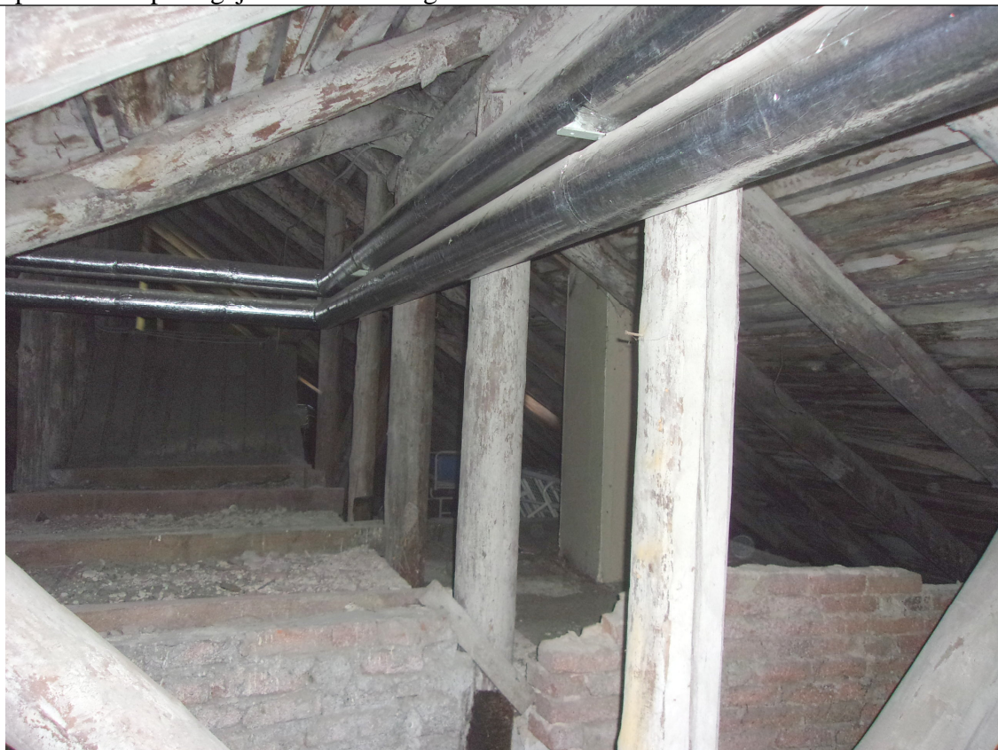
Stogo laikančios konstrukcijas šalia/virš laiptinēs ir lifto šachtos vaizdas
