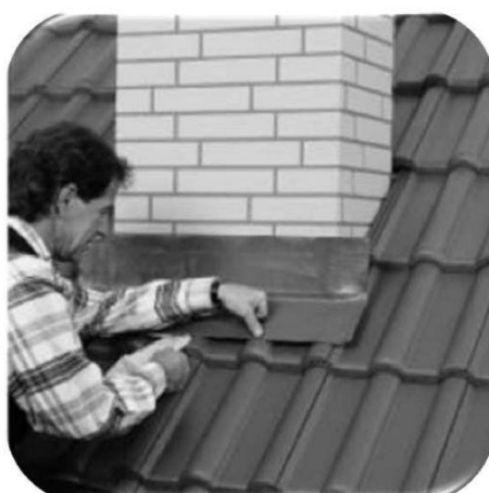
51 pav. Sandarinimo juosta fiksuojama čerpių bangų viršutiniuose taškuose
