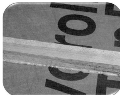
8 pav. ventiliacinių tašelių prispaudimas juos montuojant
