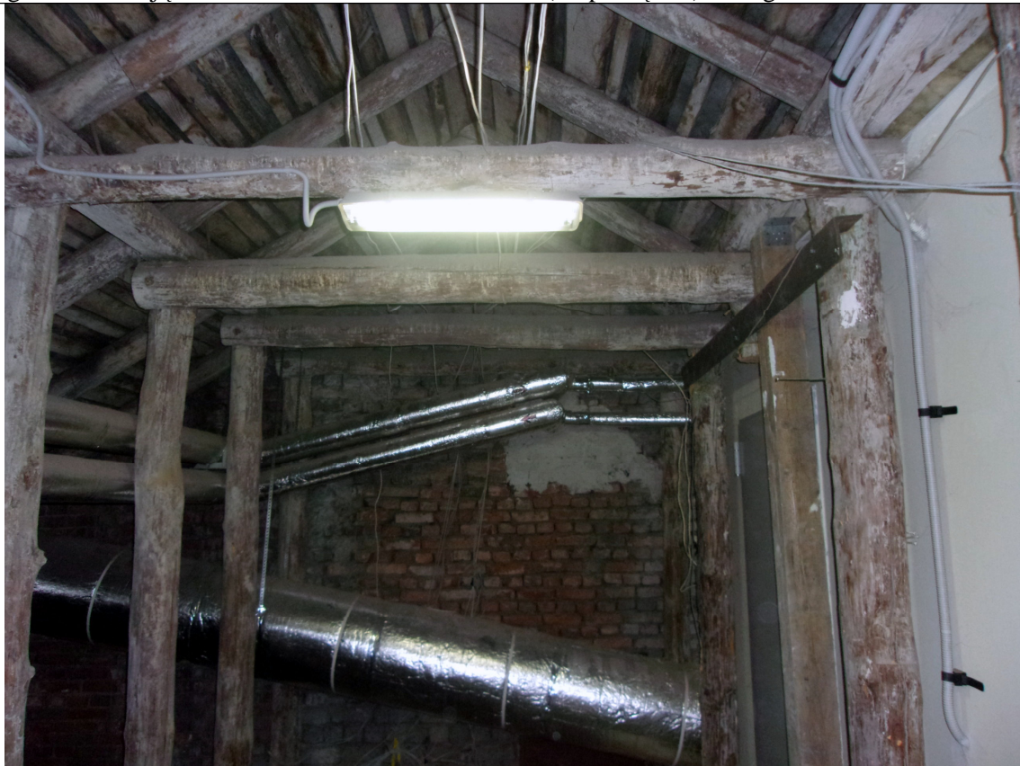
Stogo laikančių konstrukcijų vaizdas šalia esamos ventkamos ( tarp ašių 3-4). Fotografuota 2025-01-16.
