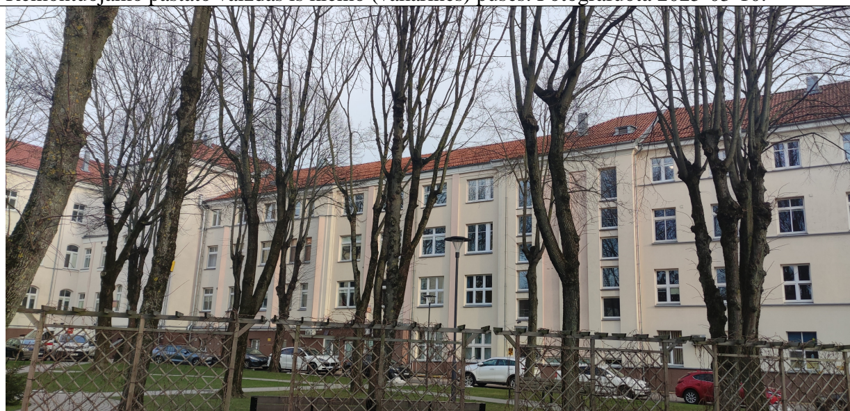
Remontuojamo pastato vaizdas iš kiemo (vakarinės) pusės. Fotografiuota 2025-03-10.
