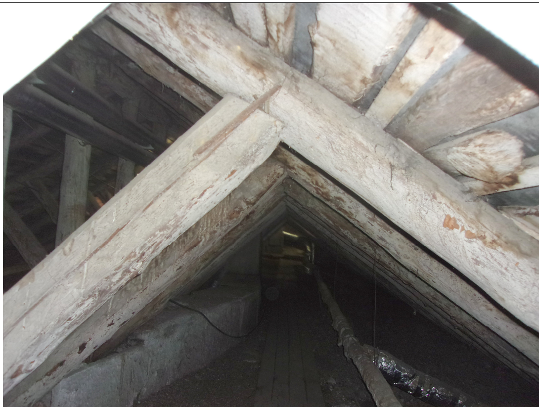
Stogo konstrukcijos mazgas - gegnė paimta centiniu spyriu. Fotografuota 2025-01-16.
