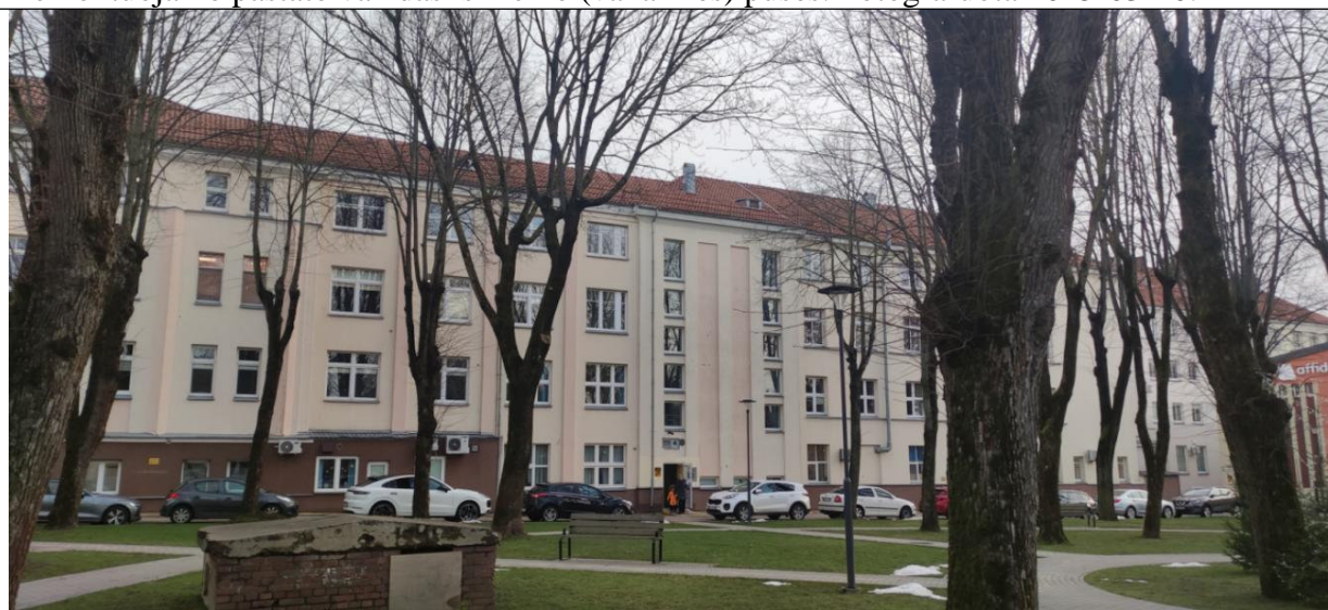
Remontuojamo pastato vaizdas iš kiemo (vakarinės) pusės. Fotografiuota 2025-03-10.
