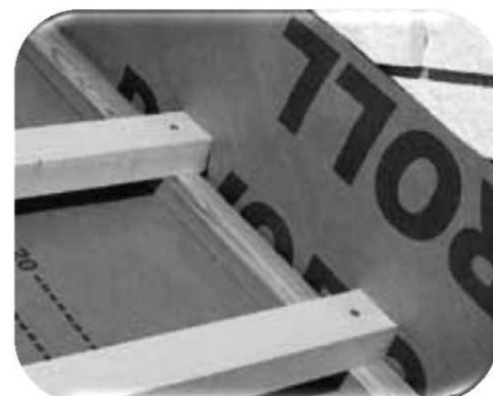
22 pav. Grebėstų įrengimas stogo šlaito plokštumos ir vertikalaus paviršiaus sandūroje
