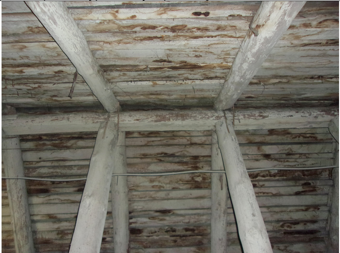
Pastato kraigo konstrukcija . Vaizdas iš apačios. Fotografuota 2025-01-16.
