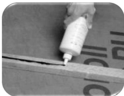
7 pav. Sandariklio tepimas ant ventiliacinių tašelių prieš juos montuojant
