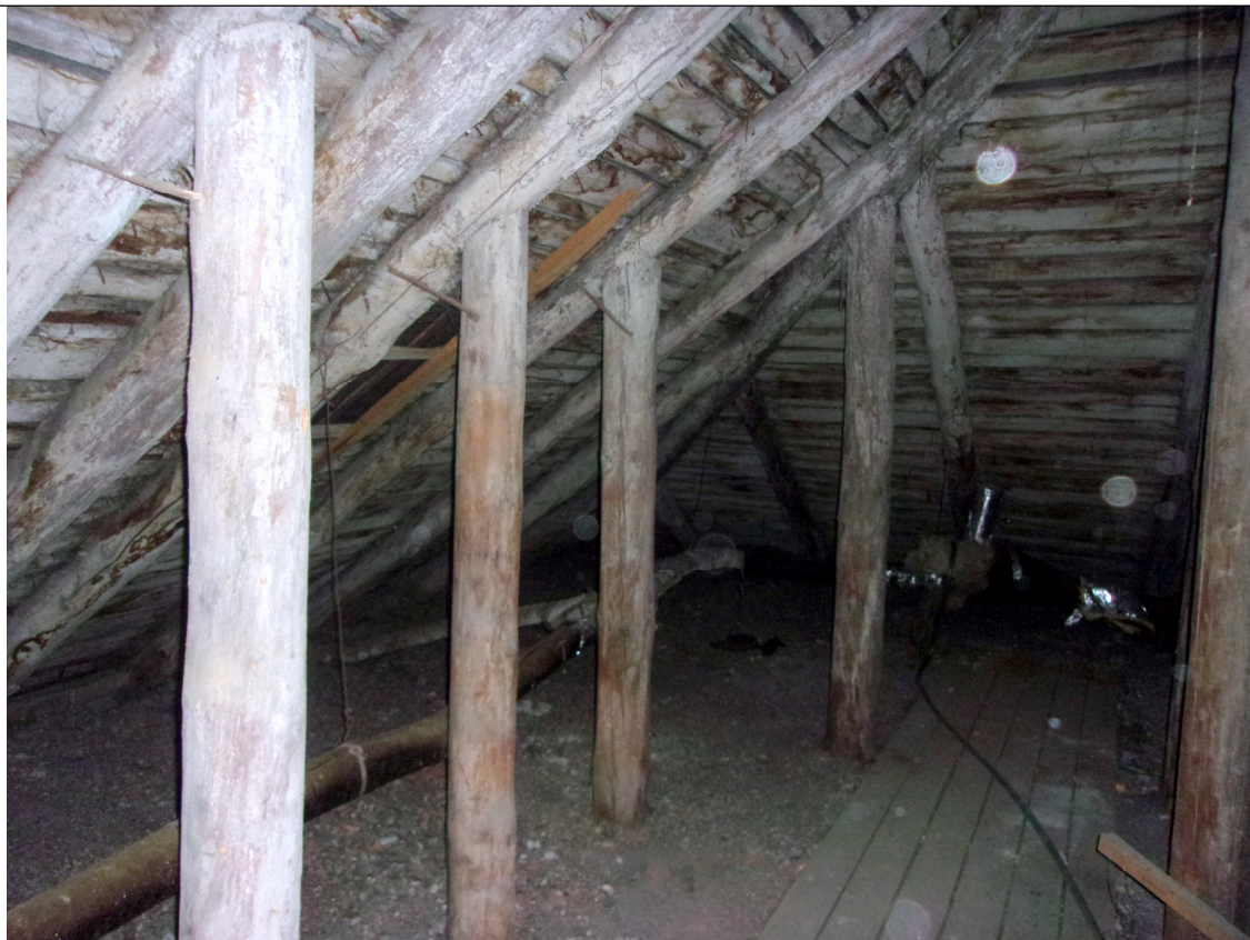
Stogo konstrukcija tarp ašiu A - C (pietinis šlaitas). Fotografuota 2025-01-16.
