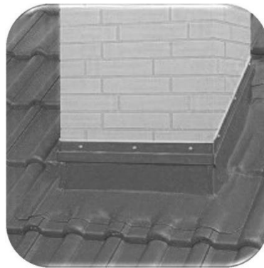
68 pav. Pilnai užsandarintas kaminas
