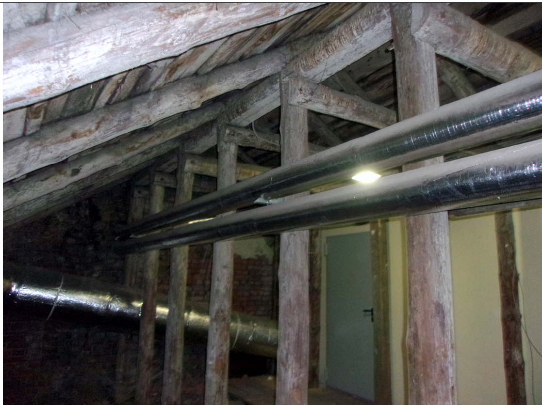
Stogo konstrukcijų vaizdas šalia esamos ventkamos ( tarp ašių 3-4). Fotografuota 2025-01-16.
