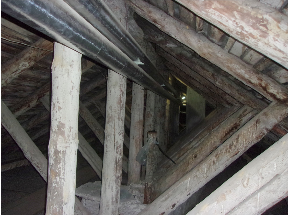
Stogo laikančių konstrukcijų vaizdas tarp ašių 2-3. Fotografuota 2025-01-16.
