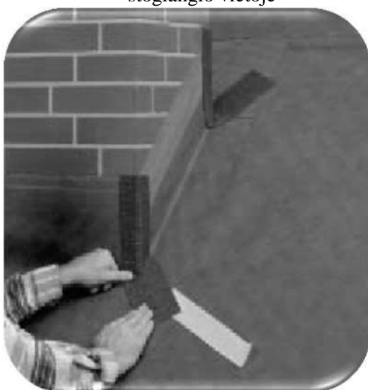
17 pav. Plėvelės užlenkimų prie kamino sandarinimas klijavimo juosta
