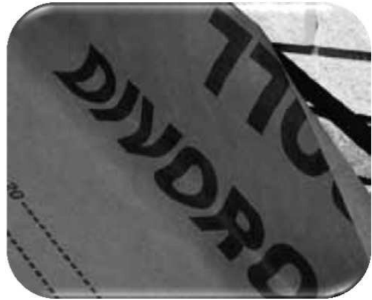
20 pav. Plėvelės įrengimas stogo šlaito plokštumos ir vertikalaus paviršiaus sandūroje
